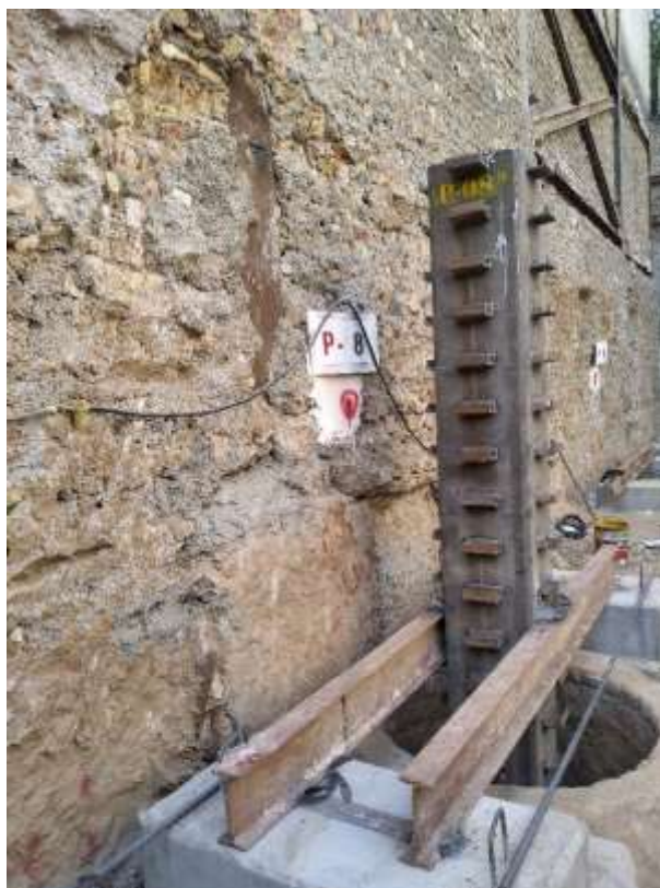
شکل ۱۶-۳ یک نمونه از اجزای نصب ستون به‌صورت معلق در سرچاه در روش بالا-پایین
