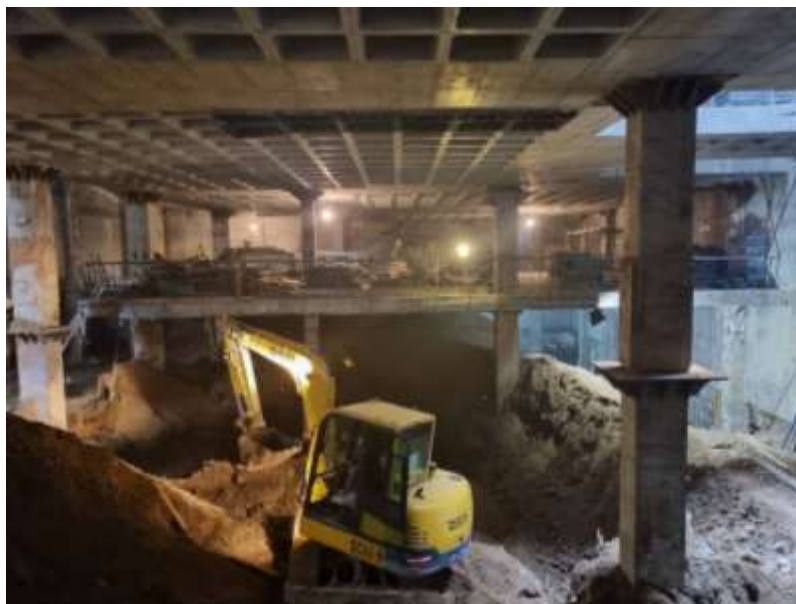
شکل ۳-۶۹ کار کردن یک دستگاه مینی‌بیل در فضای زیرزمین در اجرای سازه به روش بالا-پایین.
