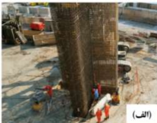
شکل ۶۲-۳ اجرای دیوار دیافراگمی به شکل T، (الف) جایگذاری شبکه میلگرد T شکل، (ب) مقطع بتنی نهایی دیوار به شکل T
