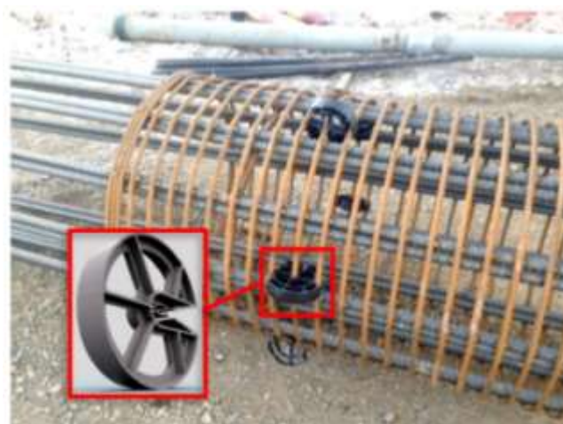
شکل ۳-۱۲ استفاده از فاصله‌گذار مخصوص سبد شمع به منظور تامین پوشش بتنی در جدار شمع.
