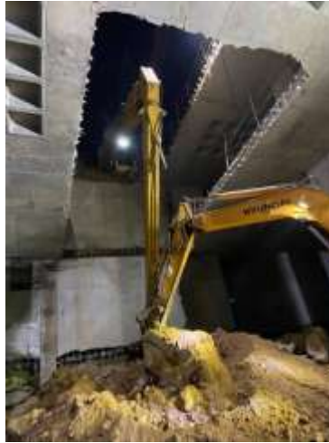
شکل ۳-۷۶ برداشتن خاک از داخل گود به وسیله بیل مکانیکی بازو بلند.
