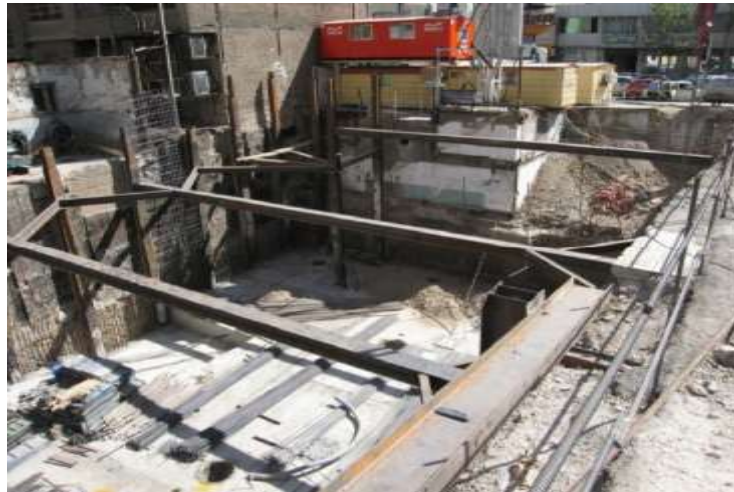
شکل پ ۱-۶ پایدارسازی گود با روش مهارمتقابل
