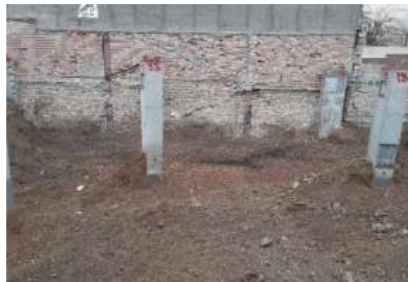
شکل ۹۲-۳ نصب ستون‌های پیش‌ساخته بتنی در سایت پس از پر کردن چاه و آماده‌سازی سایت جهت اجرای سقف و دیوار حائل اولین زیرزمین.
