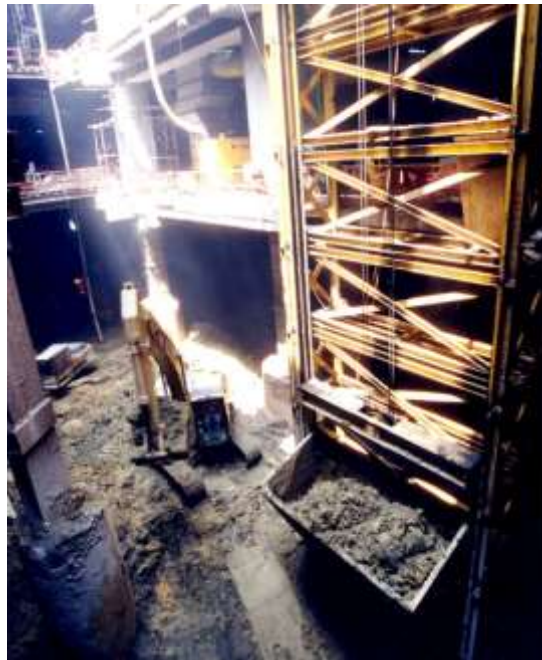
شکل ۸۶-۳ انتقال خاک به وسیله بالابر در اجرای سازه باروش بالا-پایین.
