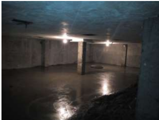
شکل ۳-۱۲۶ نمونه اجرای بتن آب‌بند بر روی فونداسیون
