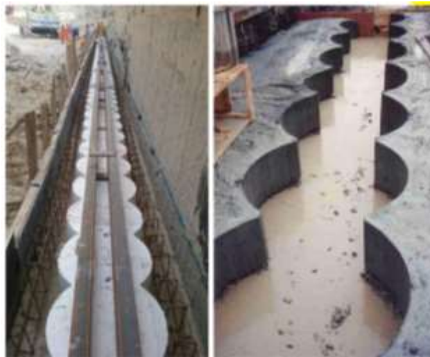
شکل ۴۶-۳ اجرای دیواره هادی بتنی در سرچاه به کمک قالب پلی استایرن در اجرای دیوار شمع مماسی.
