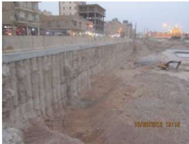
شکل پ ۱-۱۱ پایدارسازی گود با روش شمع مماسی
