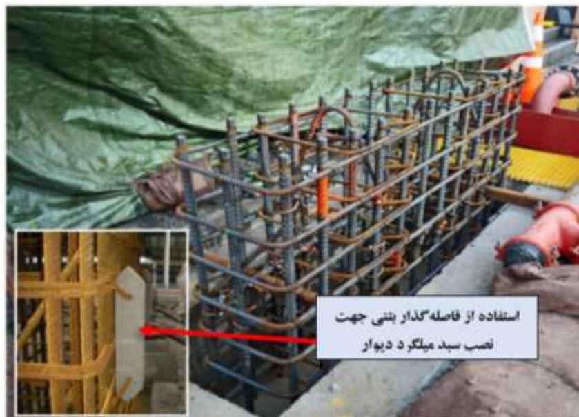
شکل ۳-۴۳ فاصله گذار بتنی در احداث دیوار بتنی
