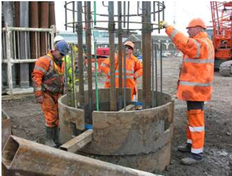
شکل ۴۵-۳ استفاده از غلاف فولادی در سر چاه جهت نصب و وصله شبکه میلگرد شمع.
