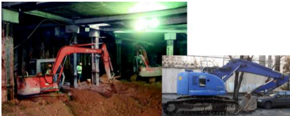
شکل ۳-۷۰ کندن خاک در زیر سقف طبقات زیرزمین و مابین ستون‌های سازه به وسیله بیل مکانیکی با اندازه متوسط در اجرای سازه به روش بالا-پایین
