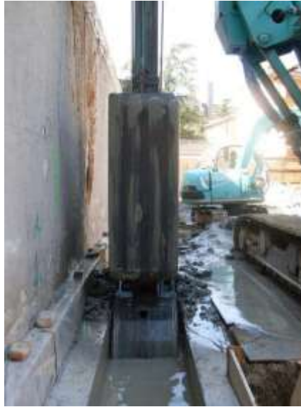
شکل ۳-۵۷ حفاری ترانشه دیوار دیافراگمی، به وسیله چنگک از طریق دیواره هادی سر ترانشه و همزمان با چرخش گل حفاری.
