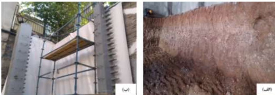
شکل ۳-۹۴ الف) قطعه‌برداری از دیواره خاکی گود و تسطیح و آماده‌سازی دیواره گود پیش از اجرای دیوار حائل، ب) اجرای عایق در روی دیواره گود پیش از اجرای دیوار حائل.
