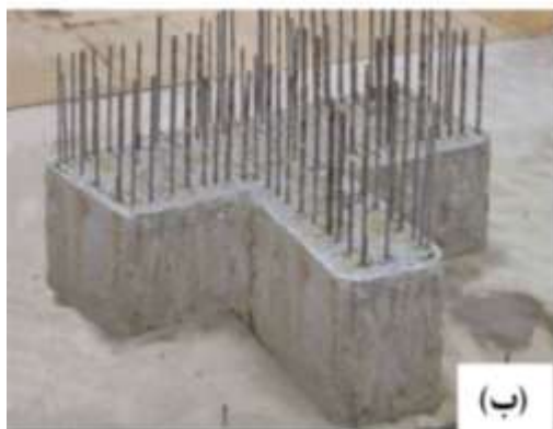
شکل ۶۲-۳ اجرای دیوار دیافراگمی به شکل T، (الف) جایگذاری شبکه میلگرد T شکل، (ب) مقطع بتنی نهایی دیوار به شکل T
