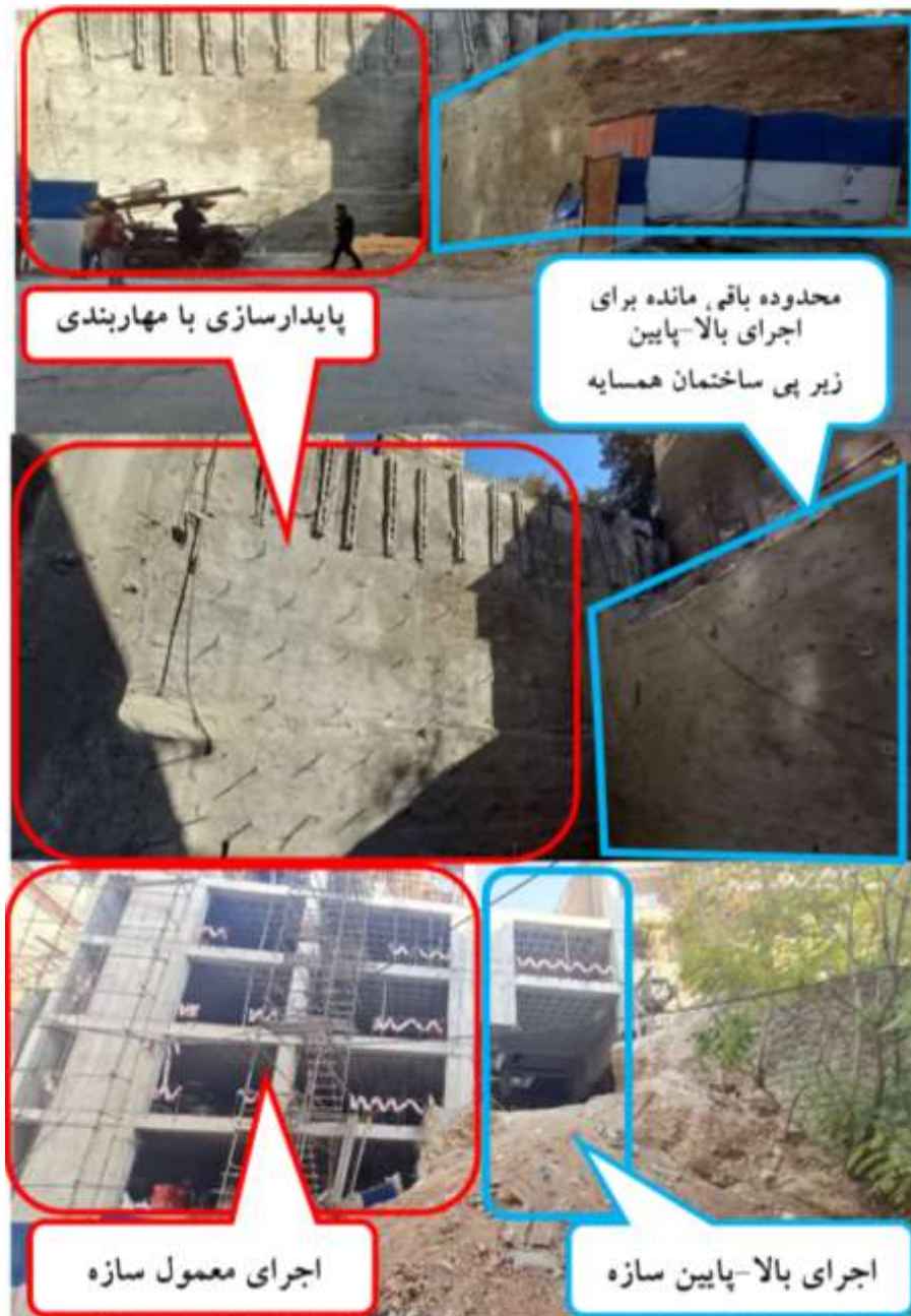
شکل ۵-۱۵ تلفیق روش مهاربندی با روش بالا و پایین - تهران، نیاوران
