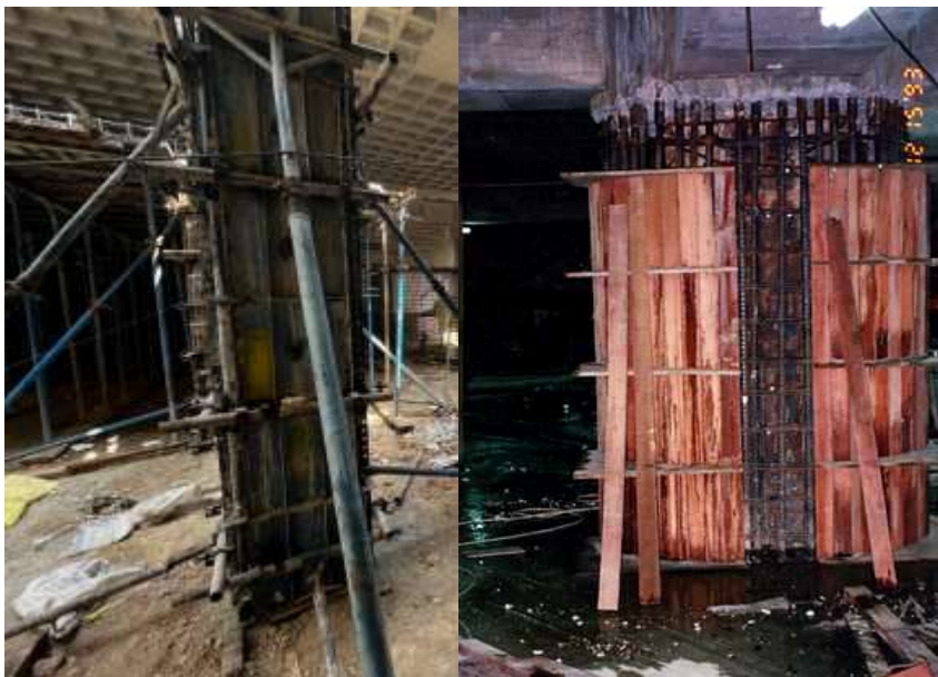
شکل ۳-۳۵ قالب‌بندی چوبی و فلزی ستون مختلط بتنی.
