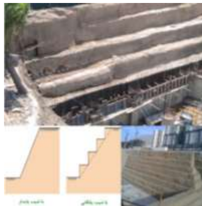
شکل پ ۱-۲ روش پایدارسازی با شیب پایدار یا پلکانی
