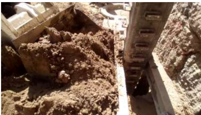
شکل ۳-۴۰ پر کردن چاه با ترکیب سیمان، آب و خاک سرنند شده محل به وسیله مینی لودر.
