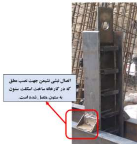
شکل ۳-۲۹ اتصال نبشی نشیمن در تراز ارتفاعی مورد نظر نصب معلق در هنگام ساخت ستون در کارخانه ساخت اسکلت.
