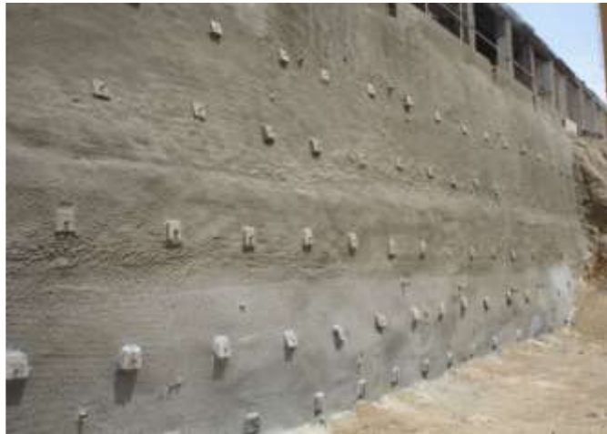
شکل پ ۱-۱۶ پایدارسازی گود با میخ کوبی دیواره
