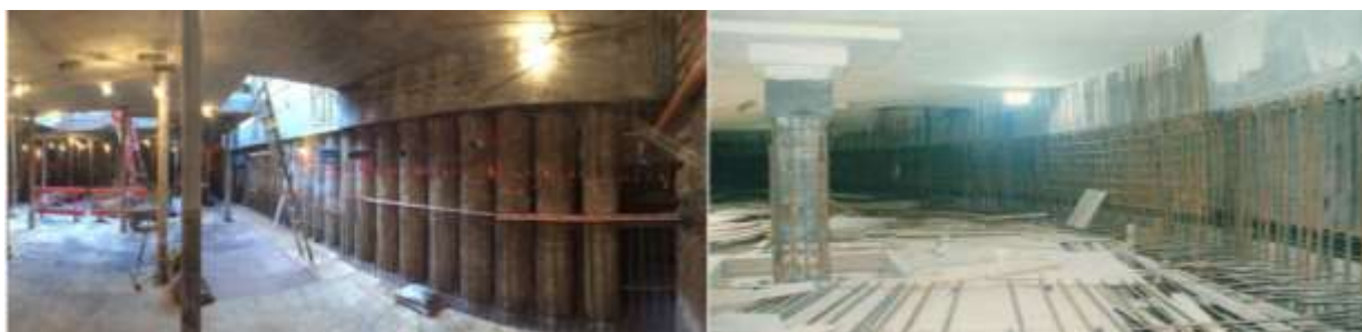
شکل ۳-۹۵ اجرای یک دیوار حائل بر روی دیوار حائل مدفون شمعی به صورت مرحله‌ای و از بالا-پایین
