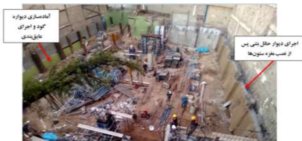
شکل ۹۳-۳ آماده‌سازی جهت اجرای بخش‌های مختلف عملیات ساخت و تعریف جبهه‌های کاری مختلف در پروژه (اسکلت بتنی و ستون‌های با مغزه فولادی در طبقات زیرزمین).
