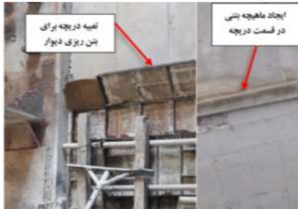
شکل ۳-۱۰۵ ایجاد دریچه در بالای دیوار برای ریختن بتن و ماهیچه بتنی ایجاد شده که باید زدوده شود
