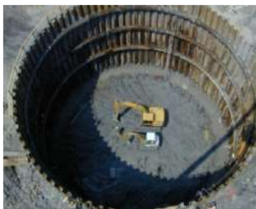
شکل پ ۱-۷ پایدارسازی گود با روش سپرکوبی
