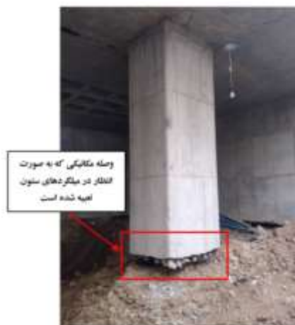
شکل ۳-۳۶ مقطع نهایی اجرا شده ستون مختلط بتنی
