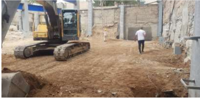
شکل ۹۱-۳ نصب ستون‌های فولادی، پر کردن چاه و سپس تسطیح کف گود به منظور ادامه عملیات اجرایی ساخت به روش بالا-پایین.
