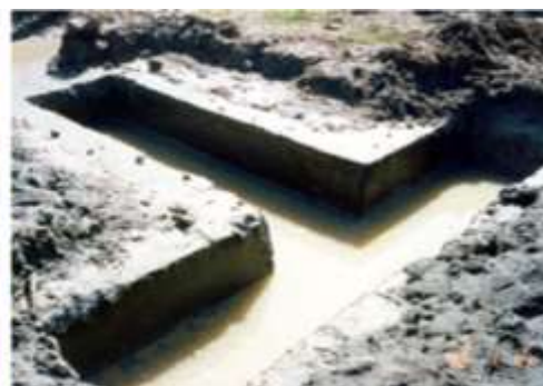
شکل ۶۱-۳ حفر ترانشه های T و صلیبی شکل به کمک ماشین های حفار هیدرومیل و چنگک
