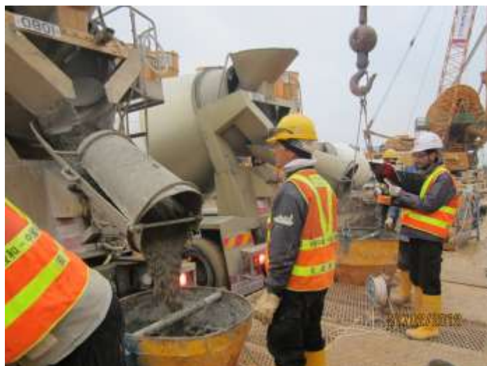
شکل ۶۰-۳ بتن ریزی قطعات دیوار بتنی به وسیله لوله های ترمی.
