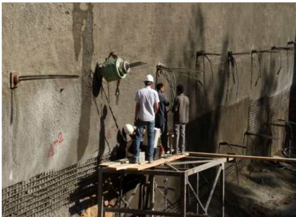
شکل پ ۱-۱۷ پایدارسازی گود با مهاربندی دیواره
