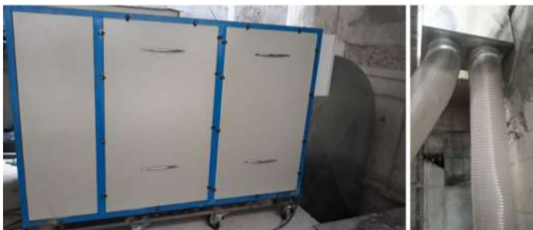
شکل ۳-۱۳۰ نمونه فن استفاده شده برای دوش هوای تازه و کانال به کارگیری شده
