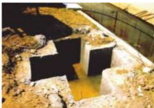
شکل ۶۱-۳ حفر ترانشه های T و صلیبی شکل به کمک ماشین های حفار هیدرومیل و چنگک
