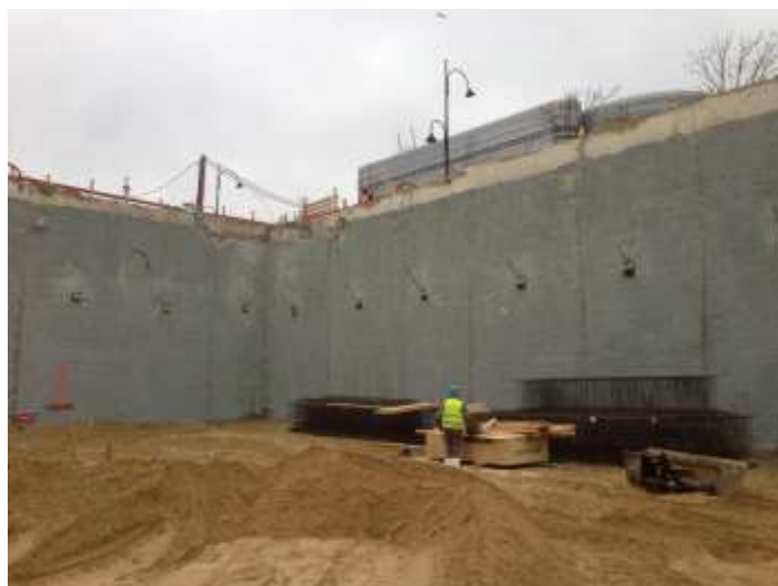
شکل پ ۱-۹ پایدارسازی گود با روش دیوار جداکننده
