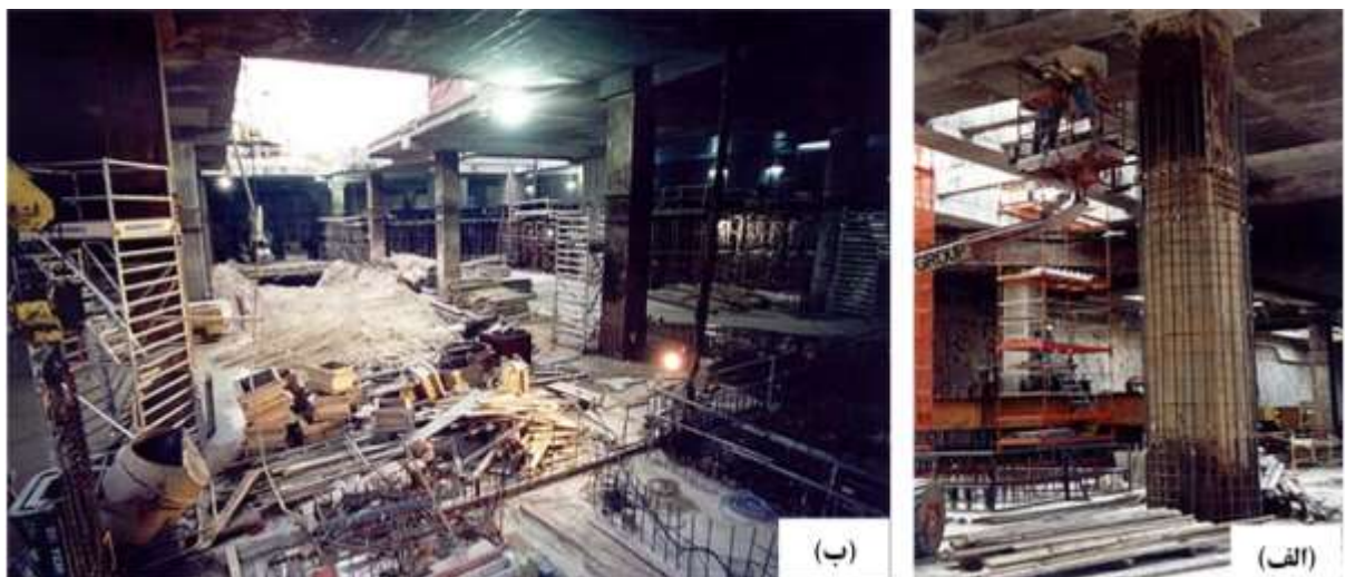
شکل ۷-۱ (الف) اجرای فرآیند بالا-پایین در طبقات زیرزمین. شمع‌های فولادی که پیش از اجرای خاکبرداری نصب شده‌اند در این تصویر دیده می‌شوند که دال سقف‌ها را نگاه می‌دارند. (ب) شمع فولادی که توسط بتن مسلح در برگرفته می‌شود و به عنوان ستون دائم طبقه زیرزمین کامل می‌گردد.
