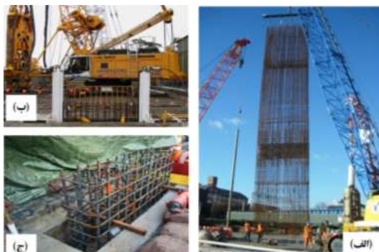
شکل ۳-۵۹ نصب شبکه میلگرد دیوار بتنی؛ (الف) قرار دادن شبکه میلگرد به کمک جرثقیل داخل ترانشه حفر شده، (ب) صفحات انتهایی که در دو سمت ترانشه قرار داده شده است در تصویر مشخص است که شبکه میلگرد دیوار مابین آنها قرار گرفته است، و (ج) معلق ماندن شبکه دیوار در سر ترانشه به کمک دیواره های هادی جهت وصله.
