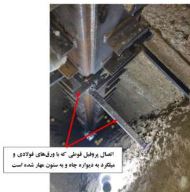
شکل ۳-۲۰ استفاده از دو پروفیل قوطی به صورت متعامد در بر ستون و جوش دادن آنها به ستون و مهار کردن قوطی به دیواره چاه به منظور ثابت کردن بخش تحتانی ستون فولادی در روش نصب معلق.
