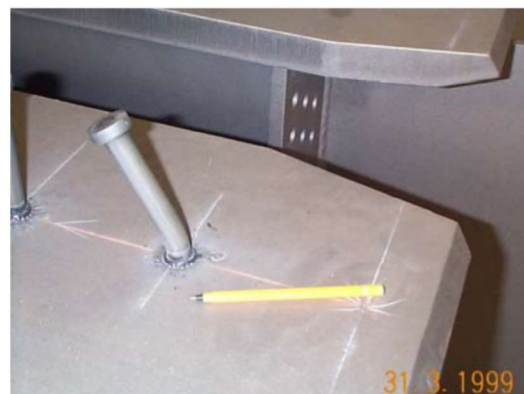
شکل ۶-۱۴ تست جوش گلمیخ
