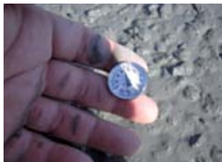
شکل ۶- کنترل دمای بتن
