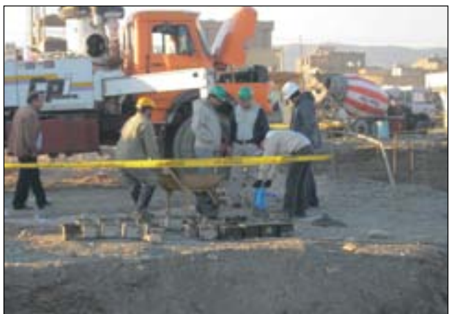
شکل ۱ - نمونه‌گیری از بتن تازه
