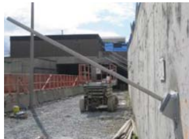
شکل ۷- قرارگیری آرماتور تسلیح در داخل لوله میکروپایل
